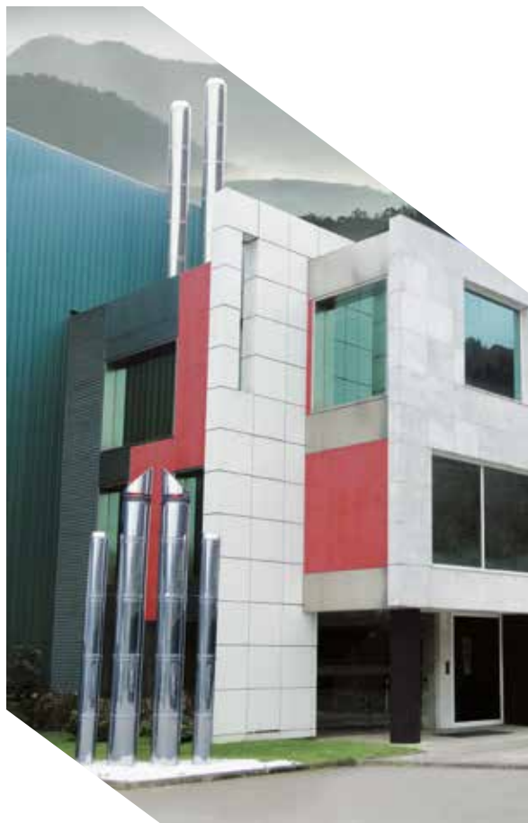
Instalaciones de Negarra en Igorre
